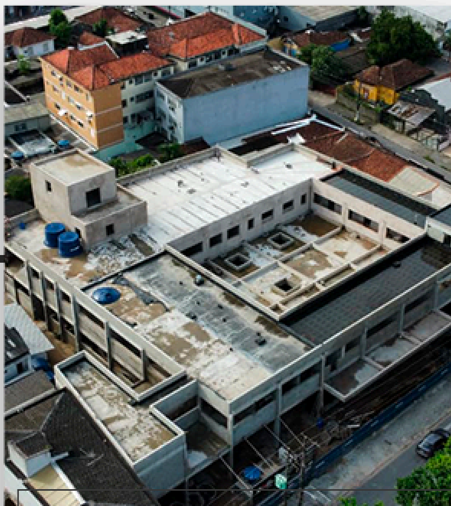
Avanços da obra da UPA Central 24h
