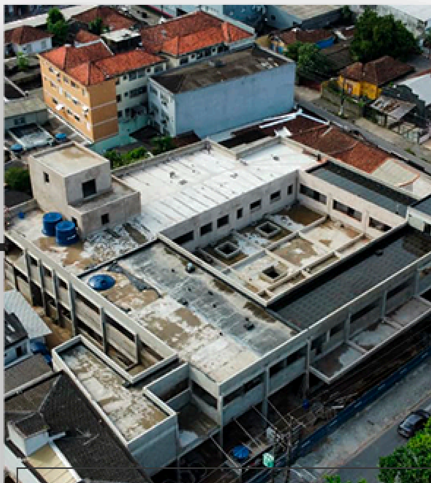
Avanços da obra da UPA Central 24h
