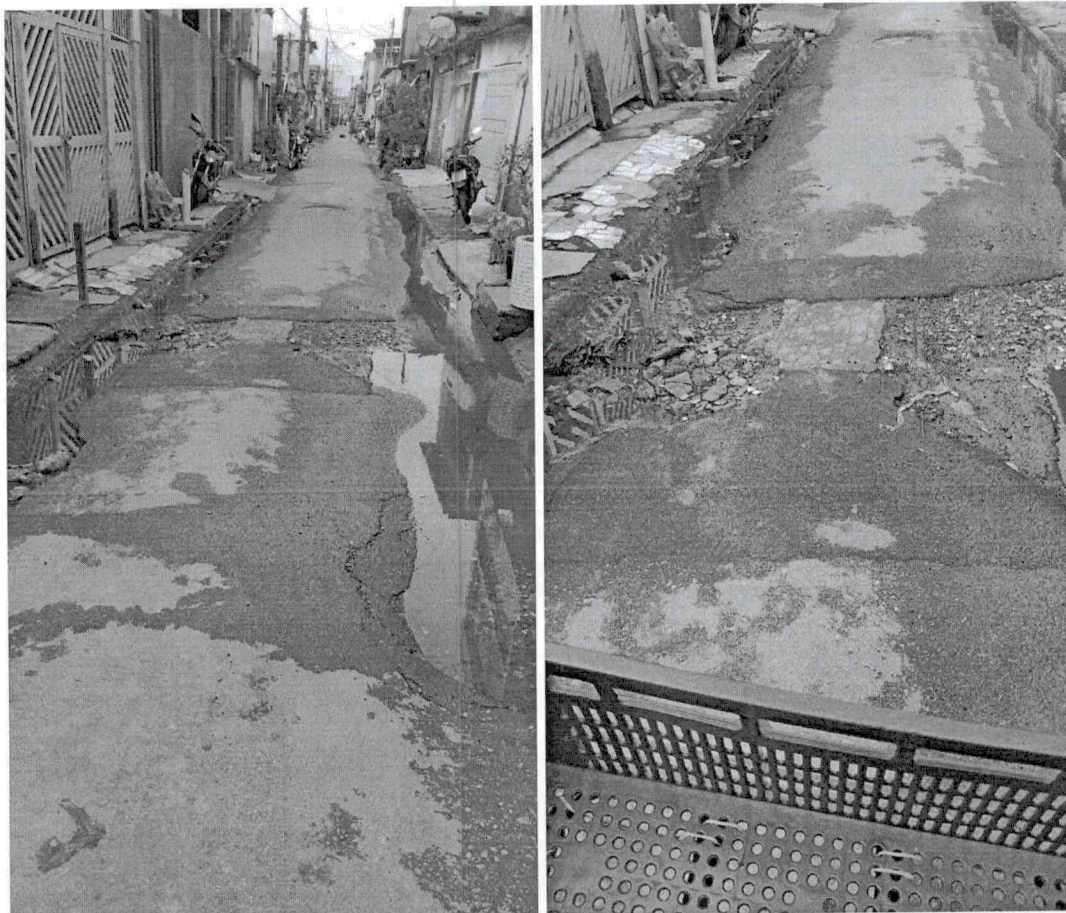
Serviço de Tapa Buracos, sito o trecho da R. Vereador João Camilo Alves Ferreira, 77 ao 84 - Vila Margarida
