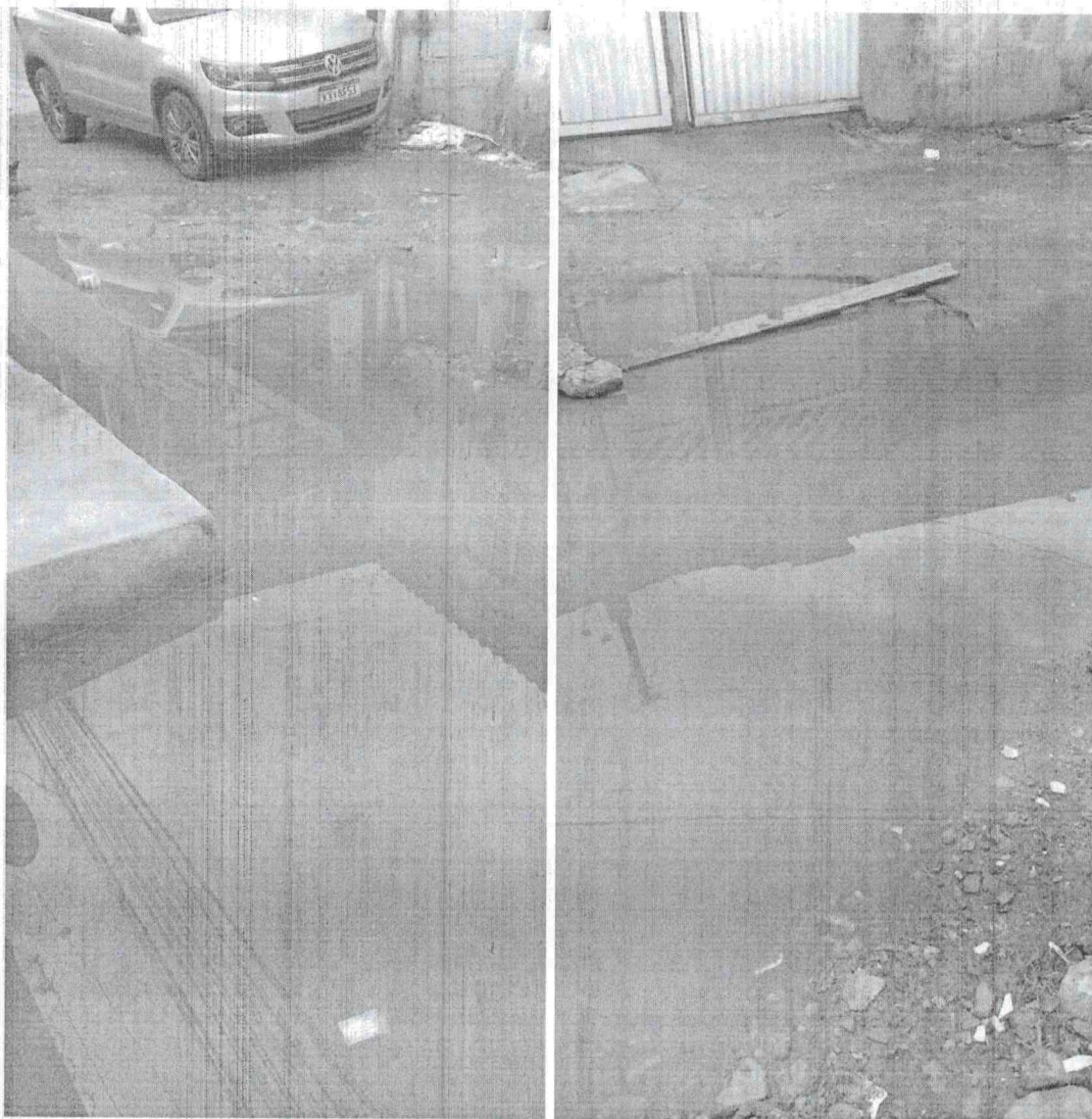
Serviço de desobstrução de galeria e hidrojato, sito a R. Vereador João Camilo Alves Ferreira, 352 - Vila Margarida.
