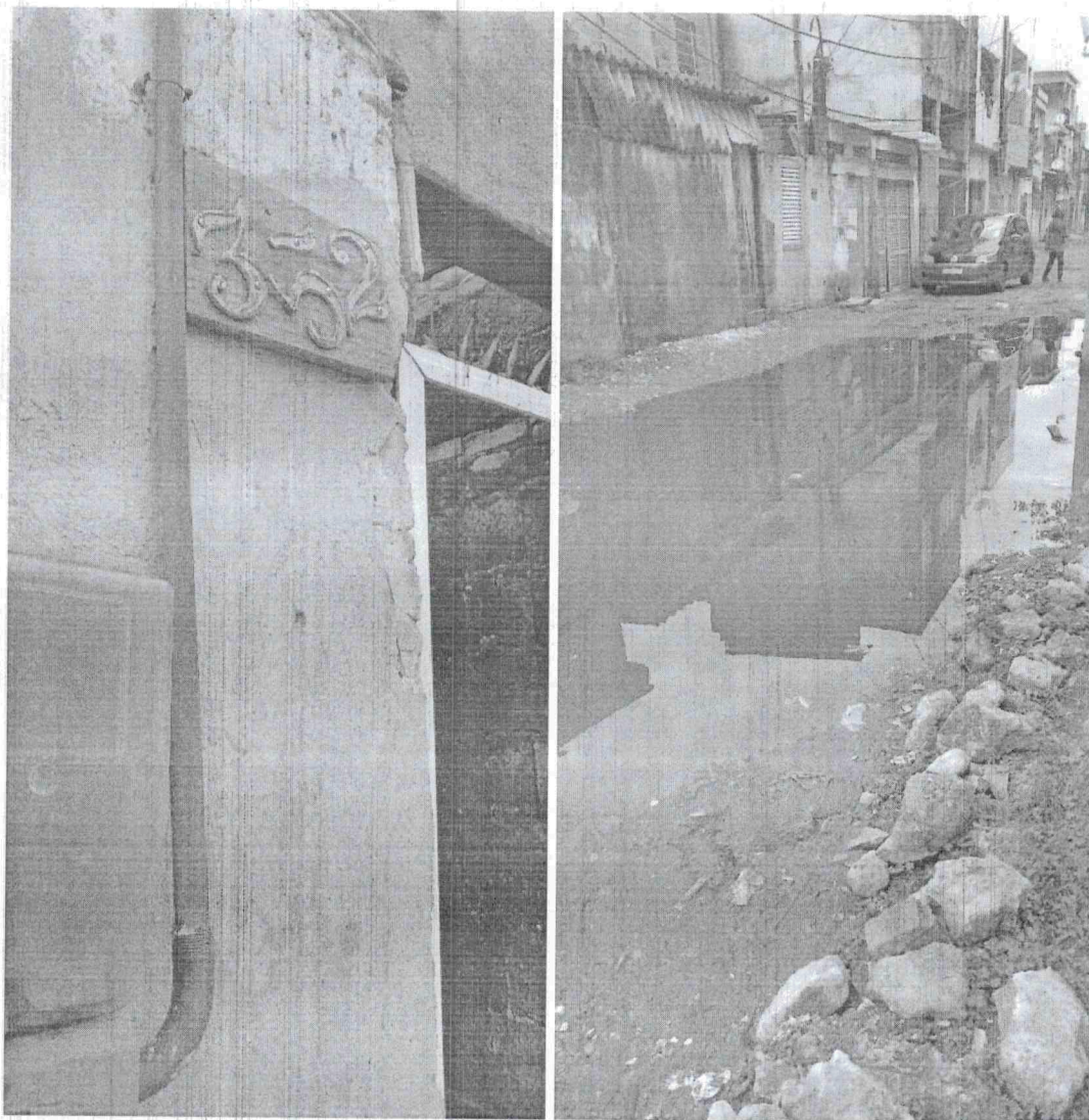
Serviço de desobstrução de galeria e hidrojato, sito a R. Vereador João Camilo Alves Ferreira, 352 - Vila Margarida
