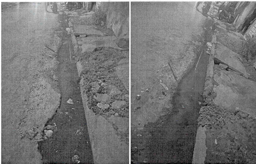
Serviço de Desobstrução de galerias e Hidrojato, sito a R. Rio Panaro, 135 - Parque Bitaru
