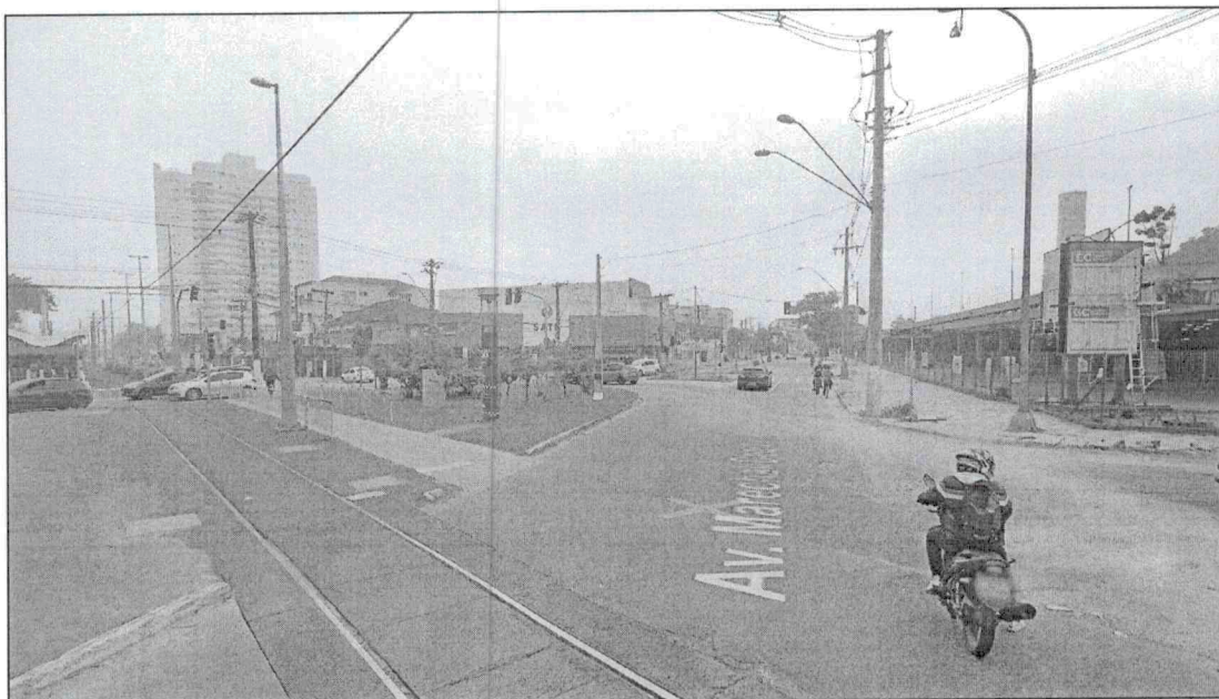
serviço de Tapa Buracos, sito a Rotatória da Av. Mal. Deodoro, com Av. Pref. José Monteiro – Jardim Independência
