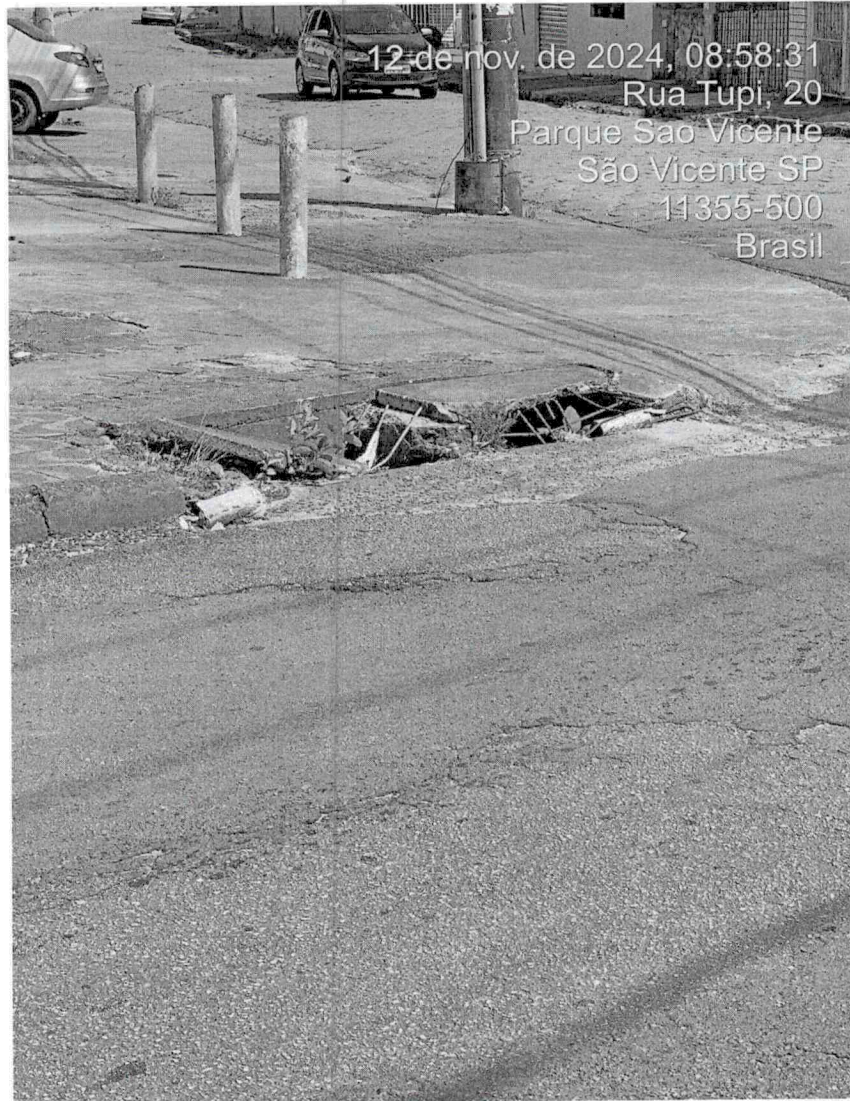
Serviço de troca de tampa de galeria pluvial, sito à R. Tupi, 20 - Parque São Vicente.
