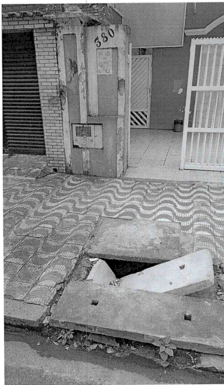
serviço de Troca de tampa de galeria Pluvial, sito a R. Messia Assú, 380 - Itararé, São Vicente.
