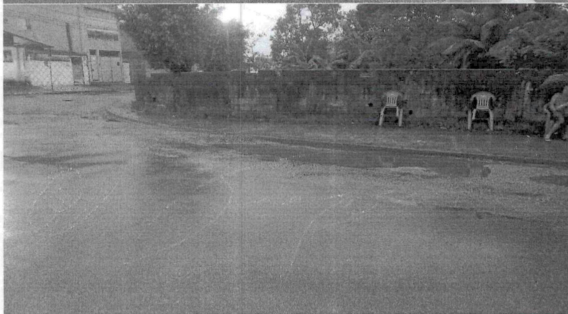
Serviço de Tapa Buracos, sito a R. Três – Vila Ema.
