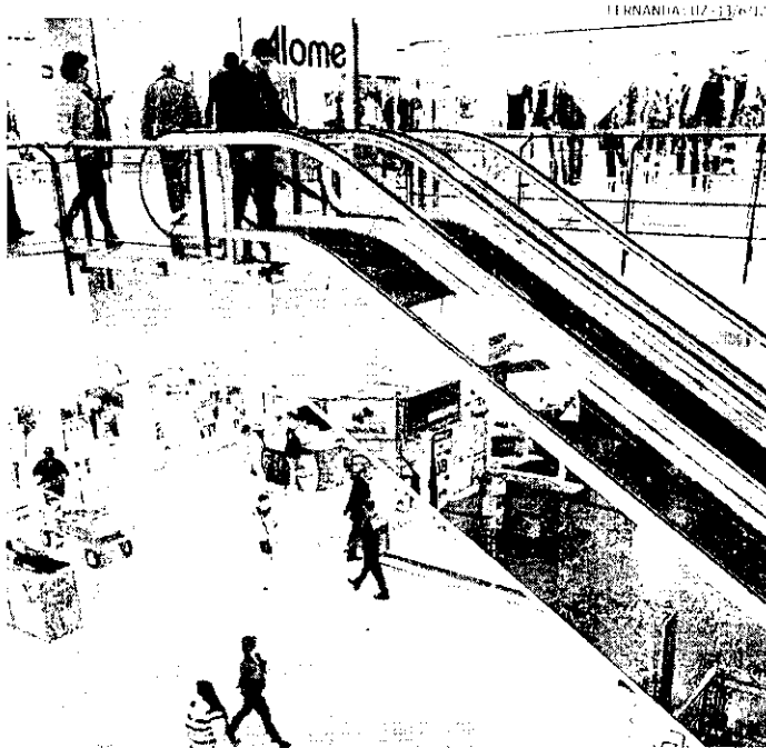
Será necessário instalar sinalização visual e tátil para esse mecanismo
