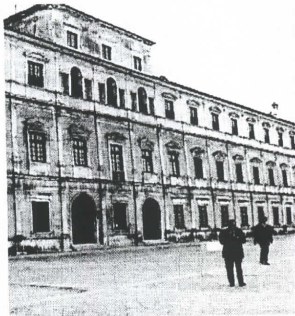
Vista frontal da Casa de Bragança - Vila Viçosa
